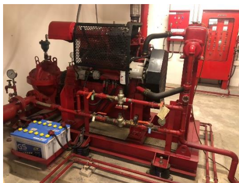
ระบบปั๊มสูบน้ำดับเพลิง
