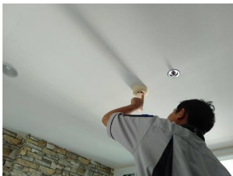
เจ้าหน้าที่ตรวจสอบเครื่องตรวจจับควัน
