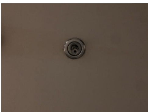
สปริงเกอร์ชนิดน้ำดับเพลิง
