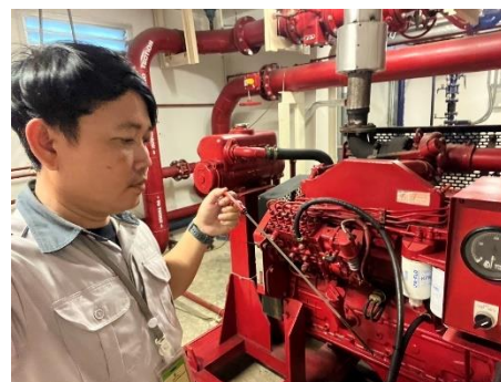
เจ้าหน้าที่ตรวจสอบ Fire Pump
